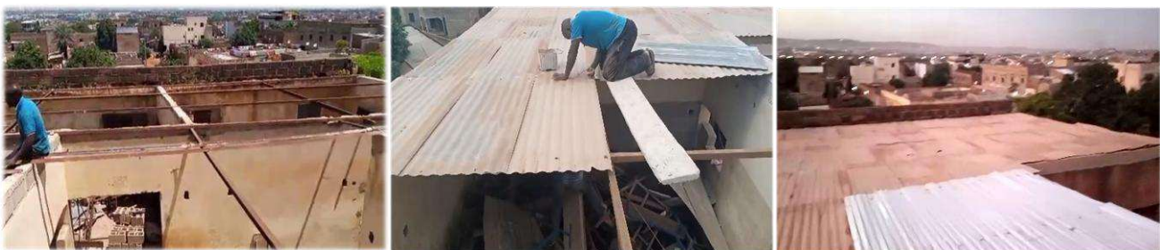
Reparatie van de daken in volle gang en het eindresultaat.
