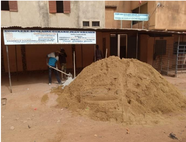
De werkzaamheden zijn begonnen voor de reparatie van plafonds en dak.
